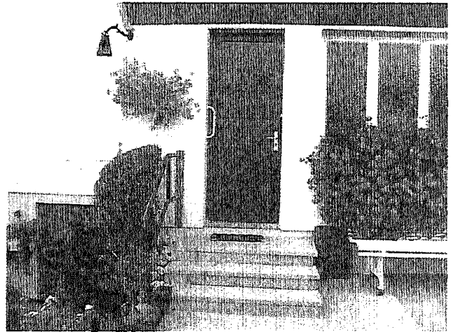
Figure 23 : Barre d'appui verticale facilitant l'entrée principale
