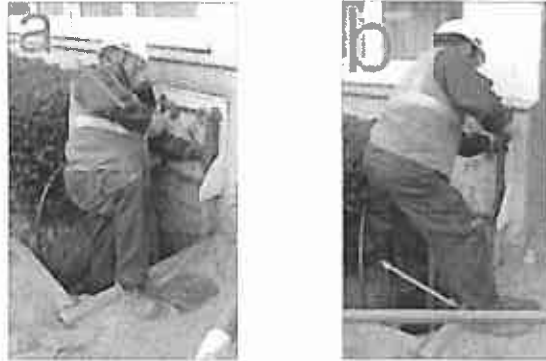
Figures 1a et 1b. Oter le boîtier solidement fixé au mur.
