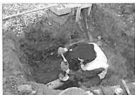
Figure 5. Mise en place de la chambre externe piégeant le gaz.
