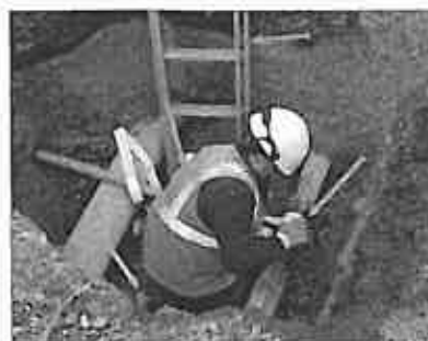
Figure 6. Mise en place du ruban protecteur
